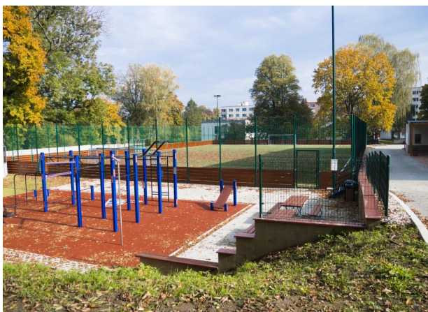
Obr . 7 - Školní hřiště v ulici Velíšská
