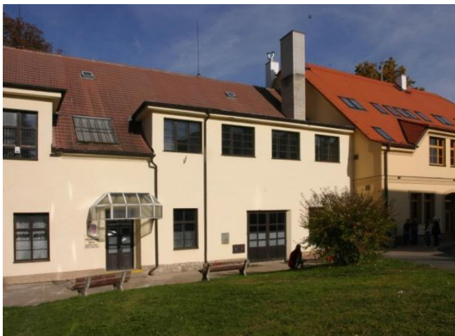
Obr . 3 - Budova školy SPŠ - Dílny, laboratoře, aula v ulici Zámecká 368
