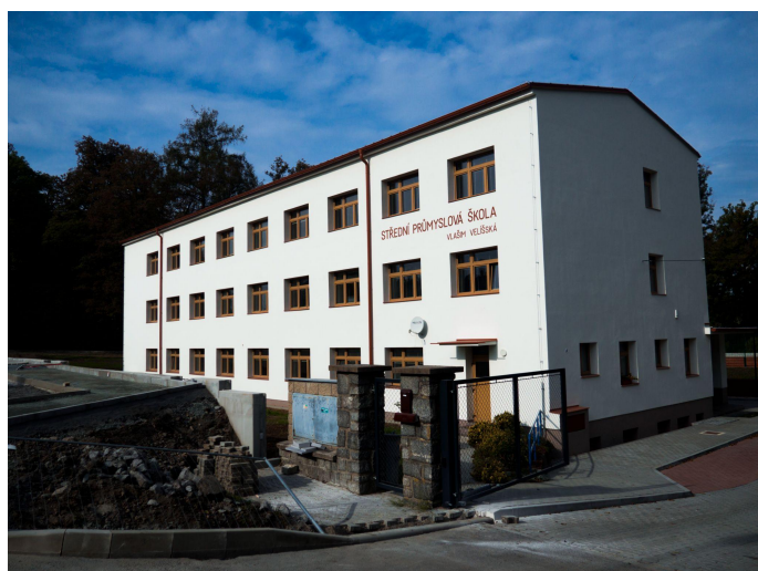
Obr . 2 - Budova školy Střední průmyslové školy v ulici Velíšská 116
